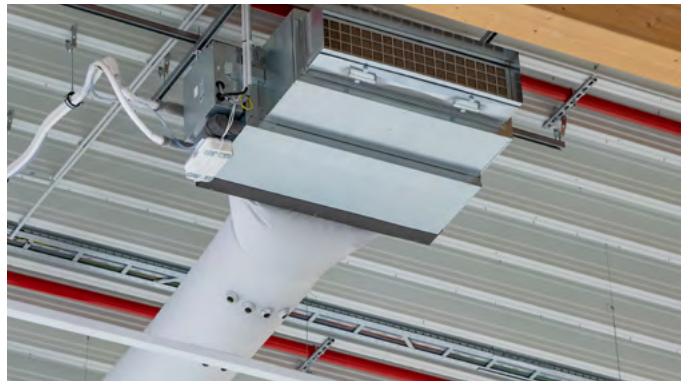
Kanalinnengerät mit Textilluftkanal
